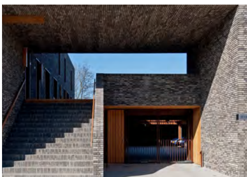
bovengronds parkeren onder een dek
